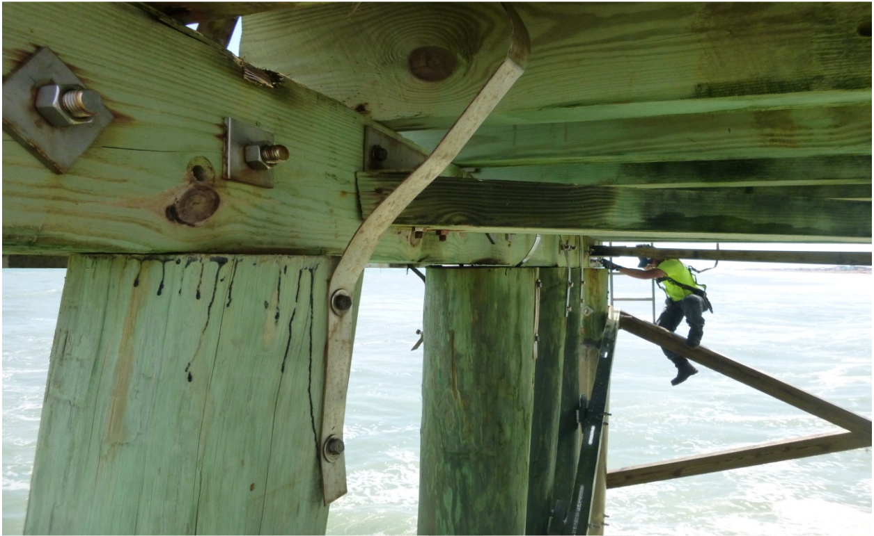
BENT 13 PILE C
