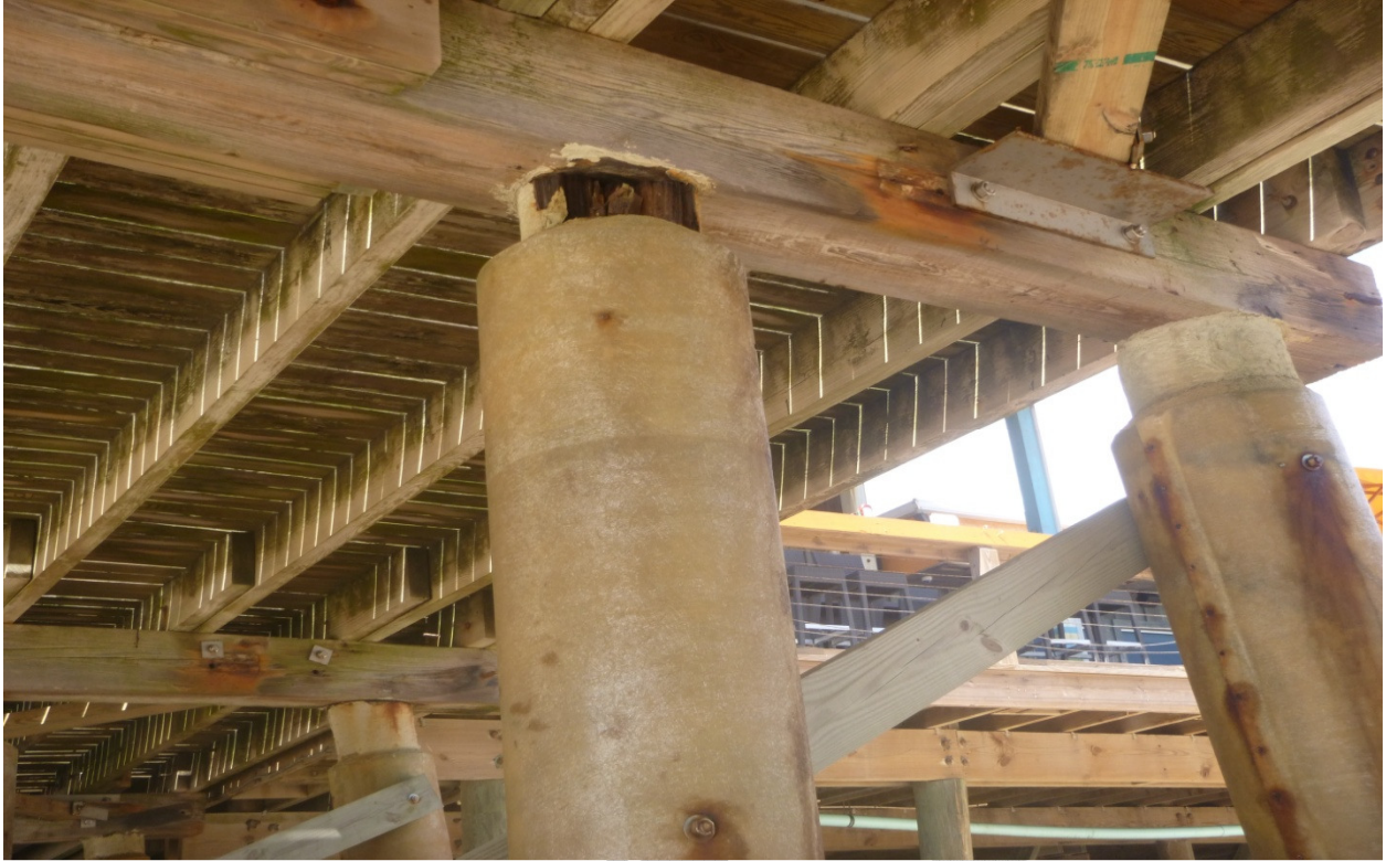
BENT 47 PILE D
