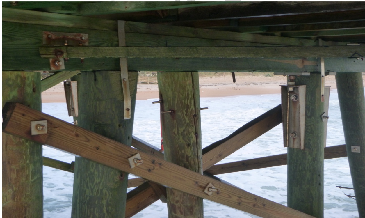
BENT 37 PILE E
